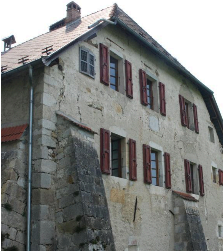
Vue d'ensemble de la façade ouest du corps de logis avec contrefort et chaîne d'angle entre les deux corps de bâtiment.
