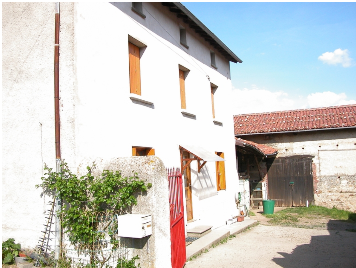
Vue d'ensemble de l'intérieur de la cour, depuis le sud-est.
