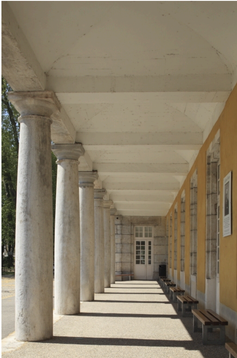
Bâtiment C. Colonnade de la façade sud.
