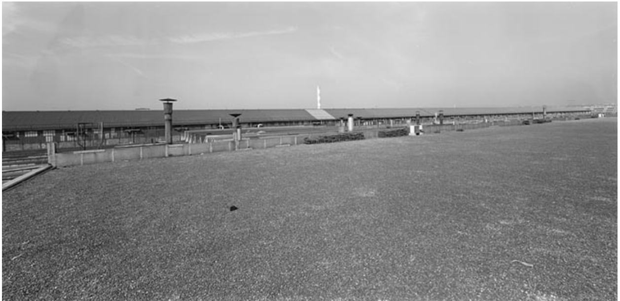
Vue nord des grands bureaux
