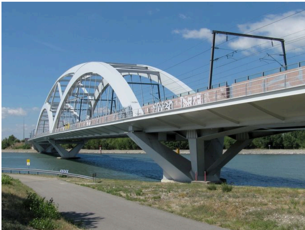
Vue du viaduc ferroviaire de La Garde-Adhémar (Drôme), face aval, depuis la rive gauche ; pont en arc à tablier suspendu, bow string (2000)
