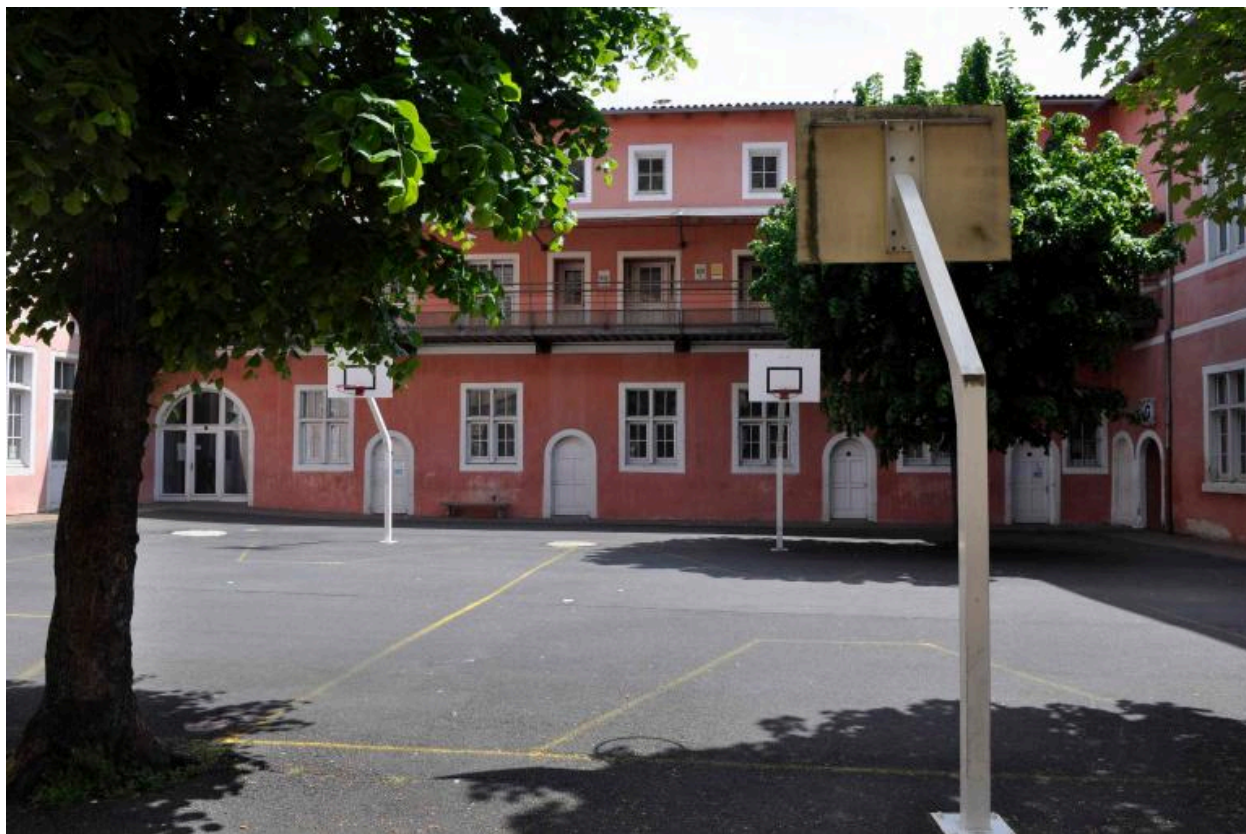
Bâtiment A : élévation sur cour 3
