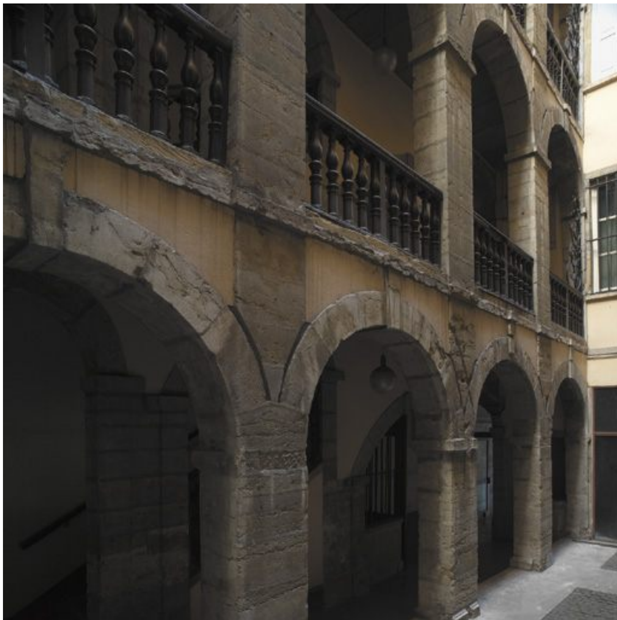
Cour : vue partielle de la cage d'escalier
