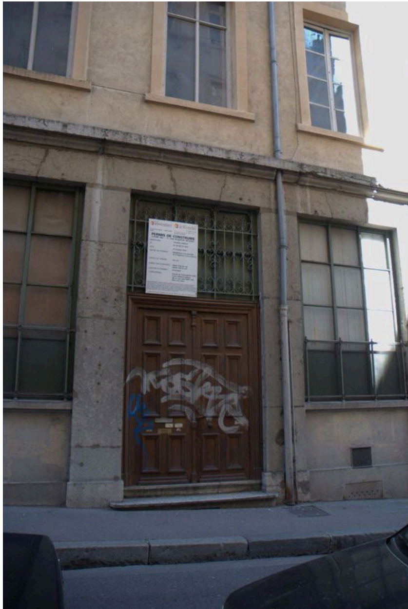
Elévation latérale, porte secondaire
