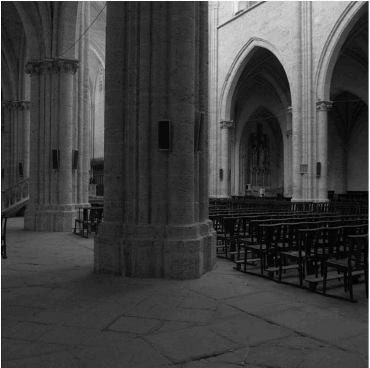
Vue intérieure depuis le collatéral nord, travée II, vers le sud-est.
