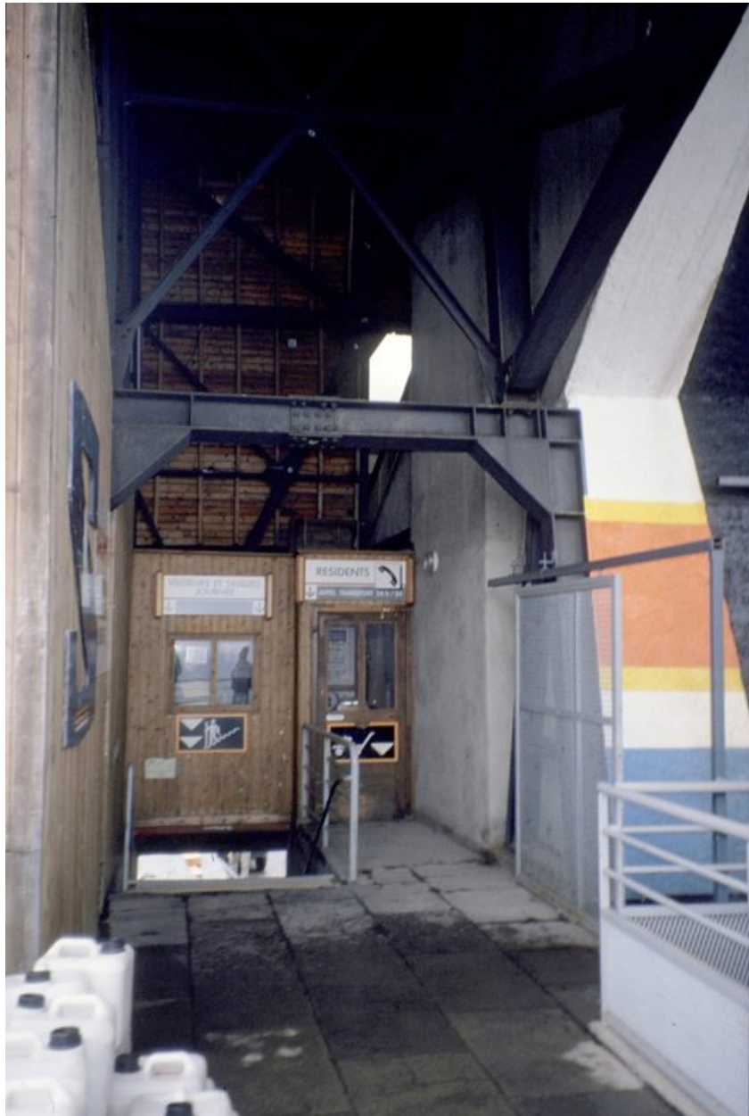
Accès à l'embarquement. Photogr. 1989
