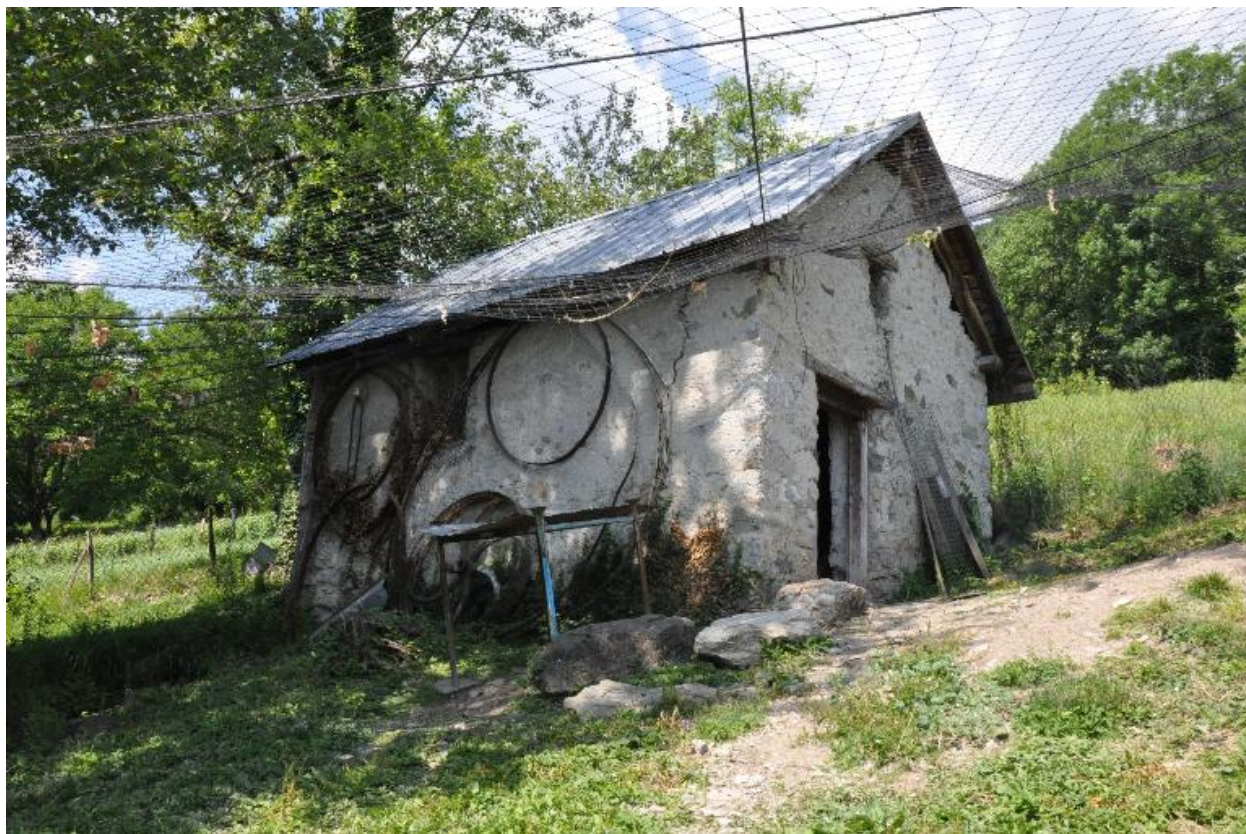
Vue du moulin amont.
