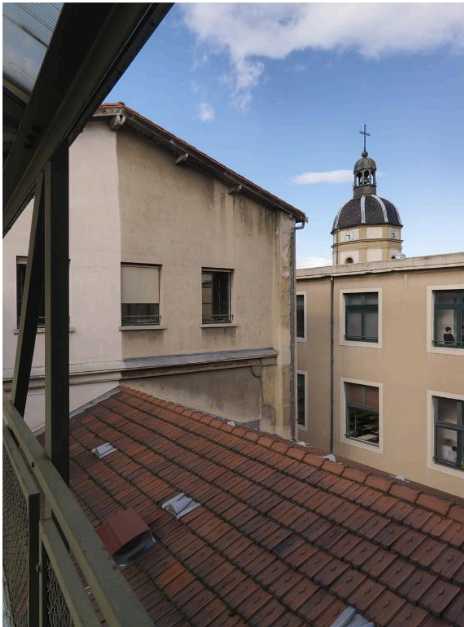
Corps de bâtiment nord, vue du pignon est
