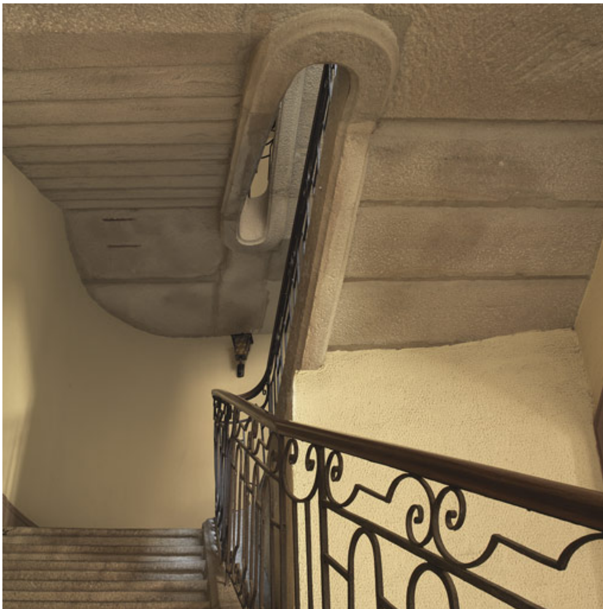
Vue partielle de la cage d'escalier, 2e moitié 19e siècle.
