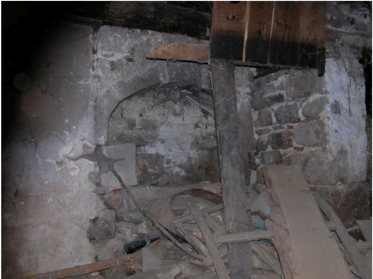
Vue intérieure du rez-de-chaussée du logis 4 : évier.
