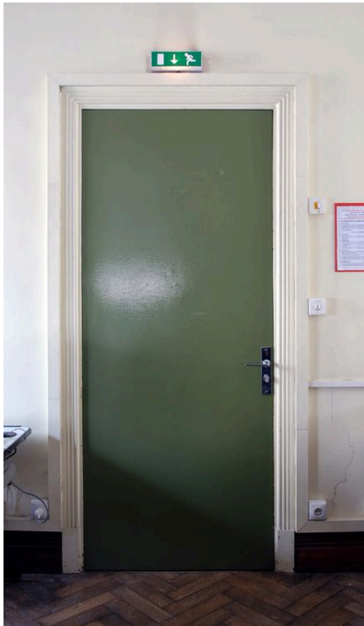
2e étage, salle à l'extrémité de l'aile sud, détail de la porte
