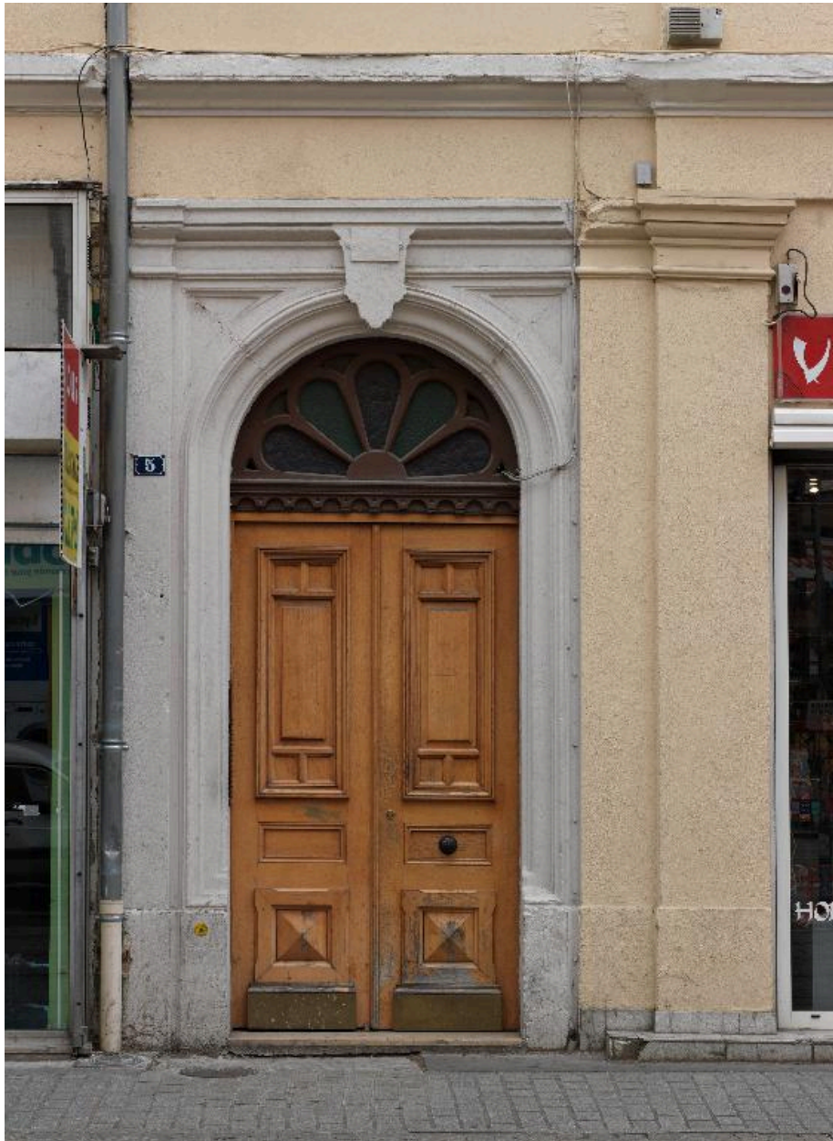
Élévation sur rue de Marseille, vue de la porte d'entrée
