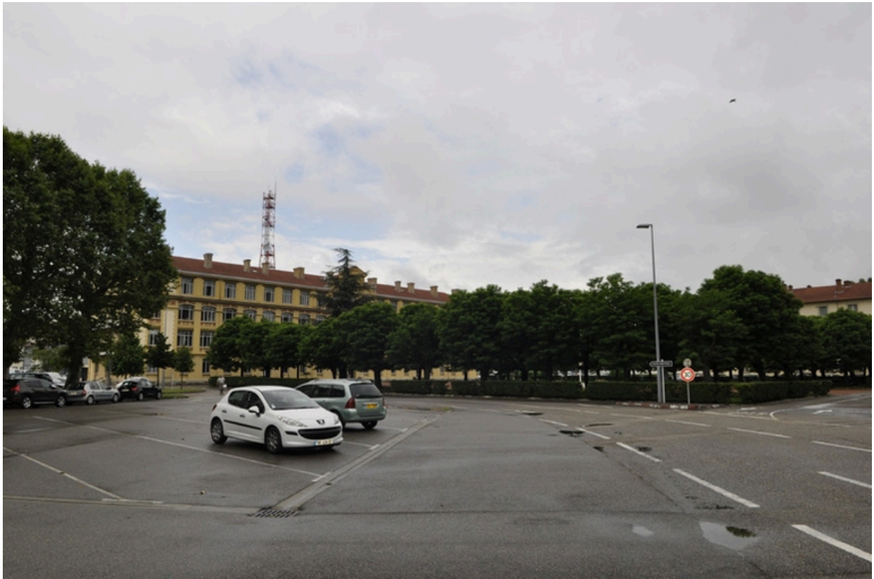
Vue du bâtiment de 1916 et de la place d'armes.
