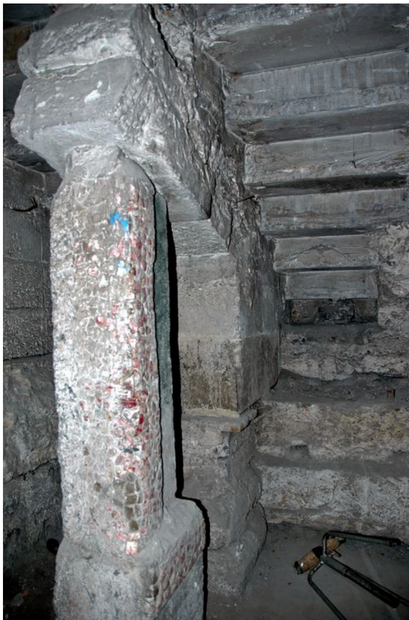
Détail des piliers soutenant la 2e volée de l'escalier principal du corps de bâtiment nord-ouest
