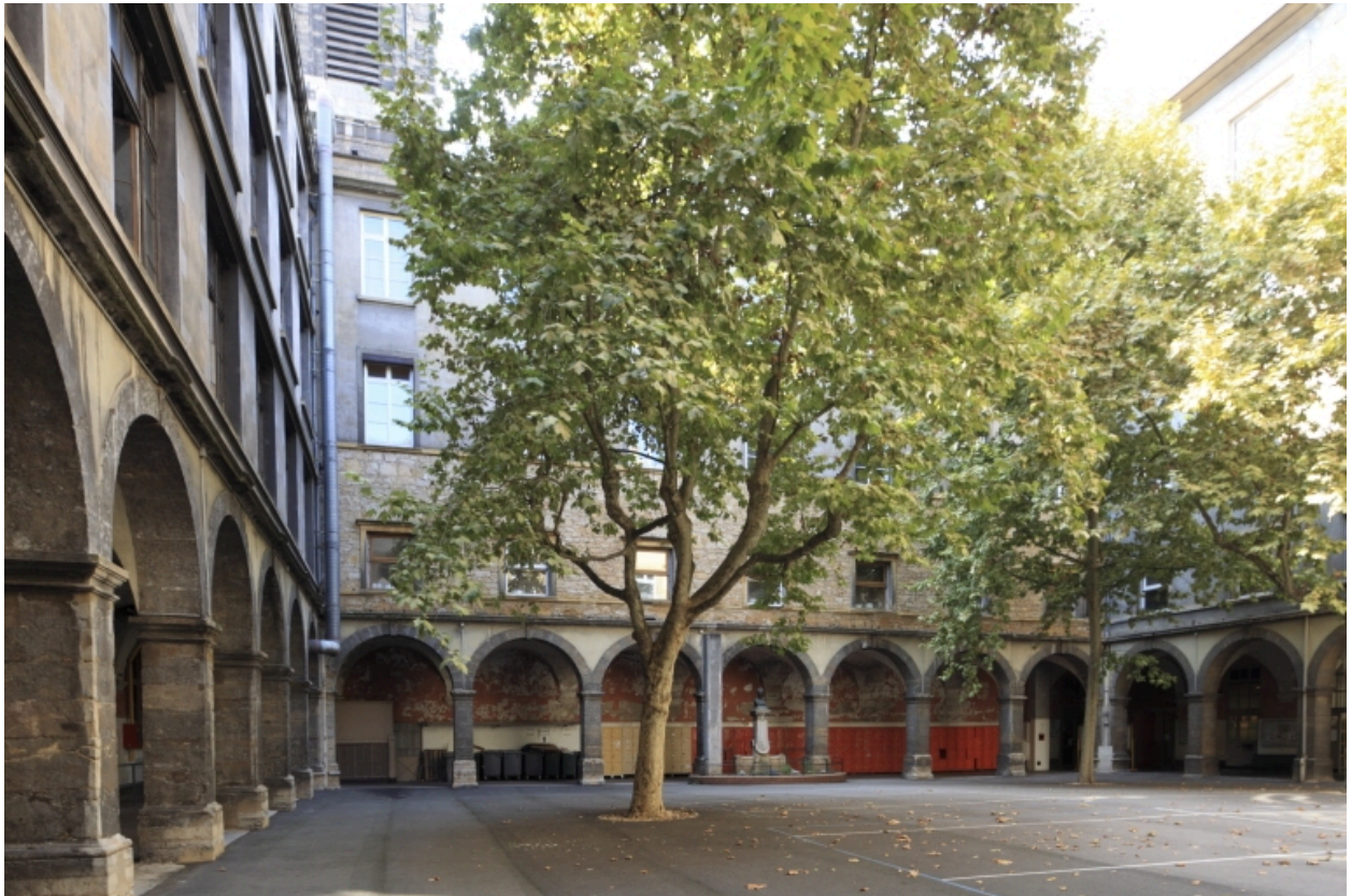
Cour du lycée. Façade est.
