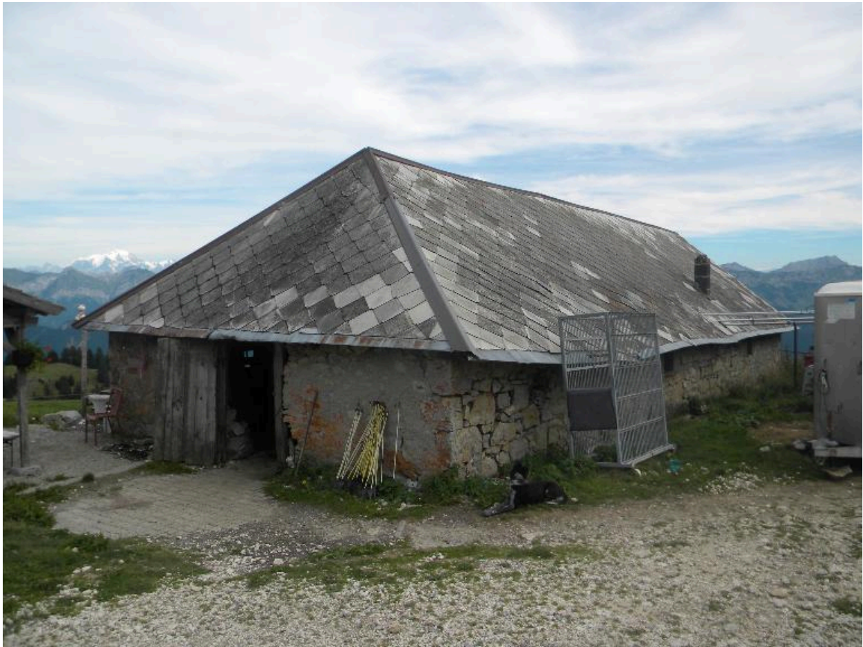
Vue de trois-quarts sud-ouest de l'étable nord en calcaire.
