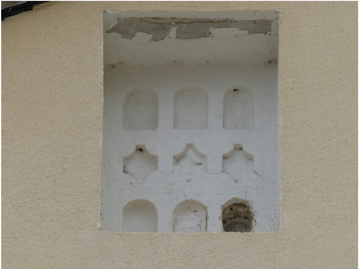
Pignon sud, baie du pigeonnier.
