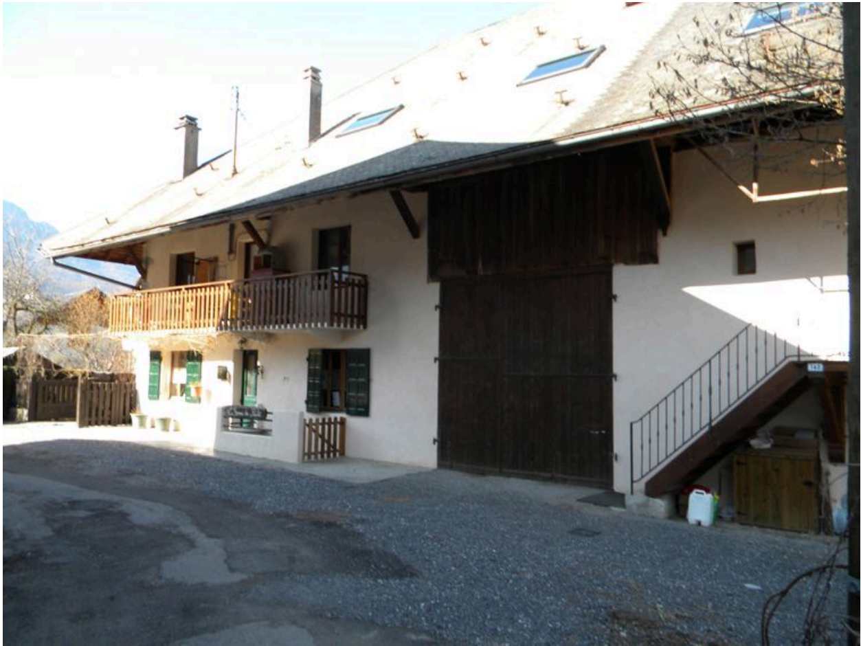
Vue de la façade sud avec la grange au centre.
