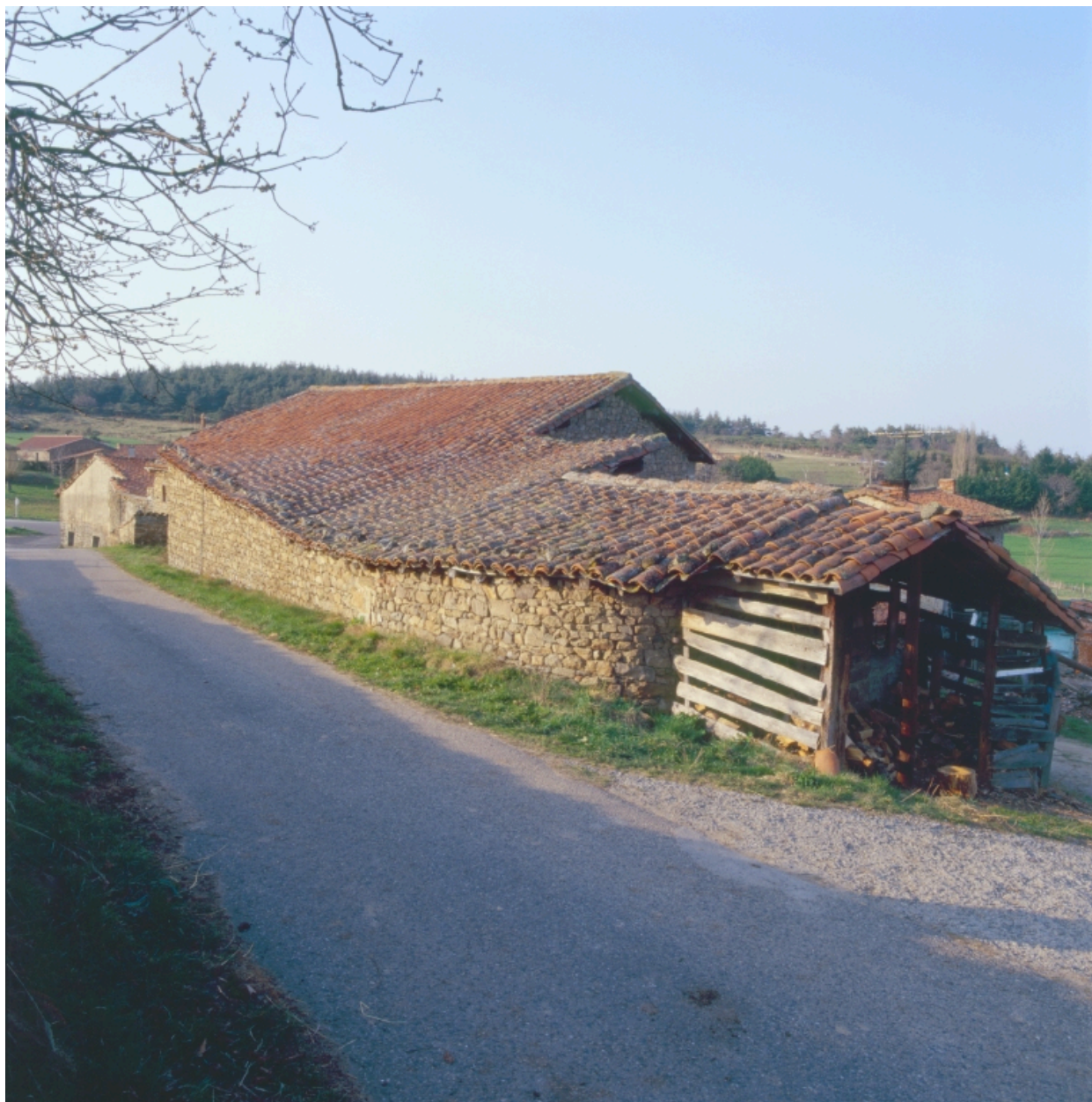
Marcoux, Bruyère (1986 B3 786), type A1. Vue d'ensemble des toitures depuis le chemin, au sud.
