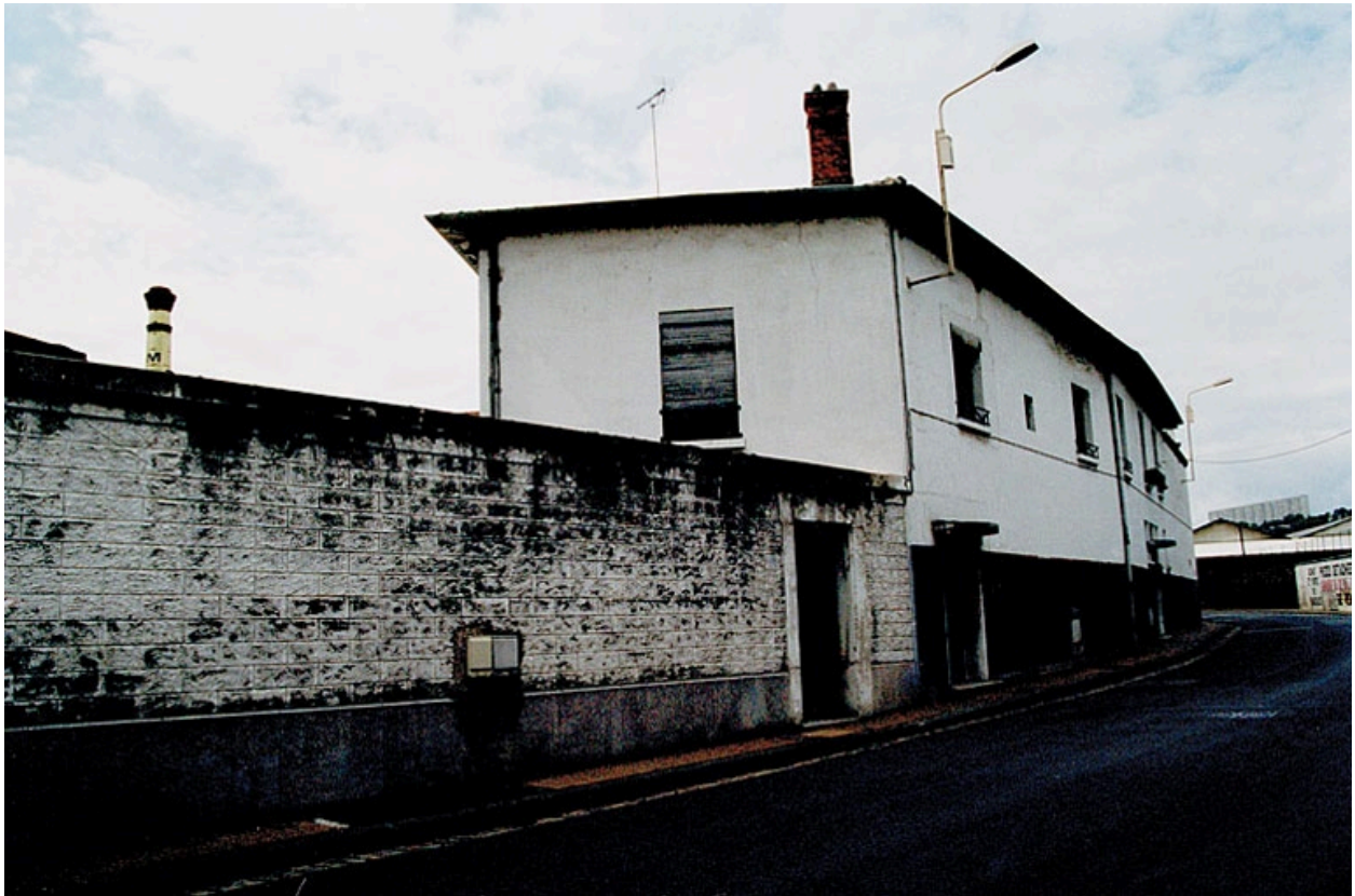
Détail façade ouest
