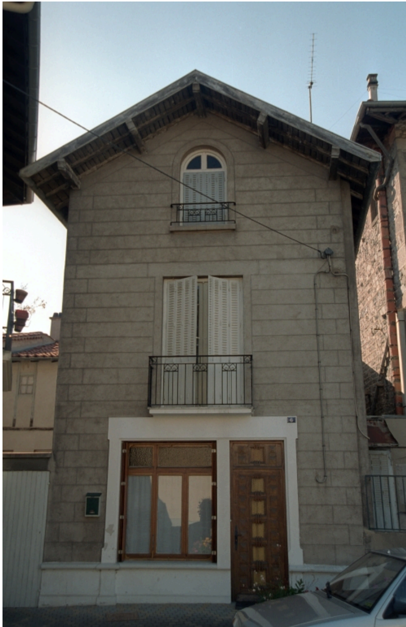
Boën, îlot 18, Emile Mandrillon (place) 6. Vue générale de la façade sur rue.
