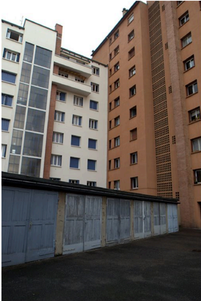
Elévation postérieure. L'accroche du bâtiment avec l'immeuble rue Garibaldi
