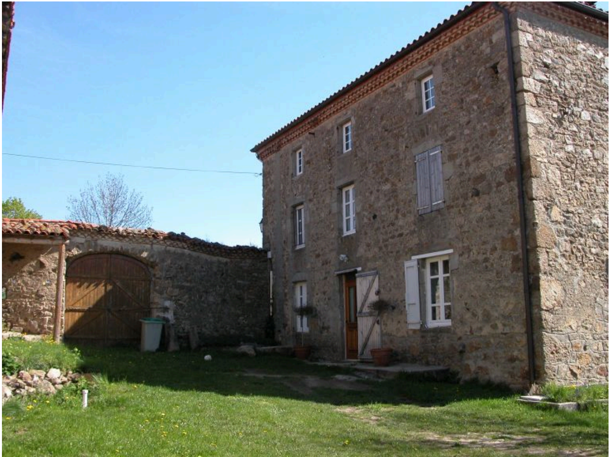
Vue d'ensemble du logis de trois-quarts avant droit.
