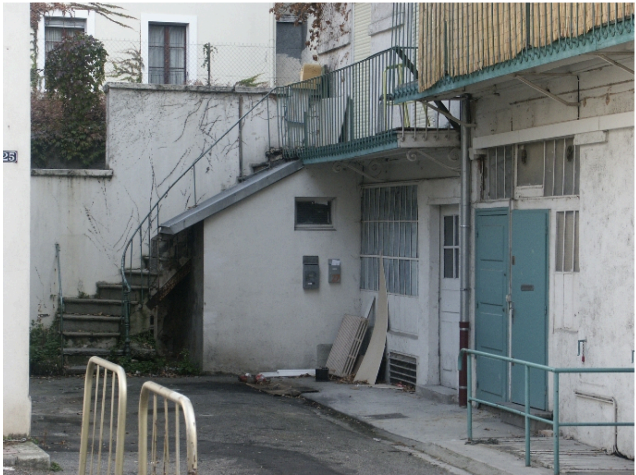
Détail de la façade sur cour
