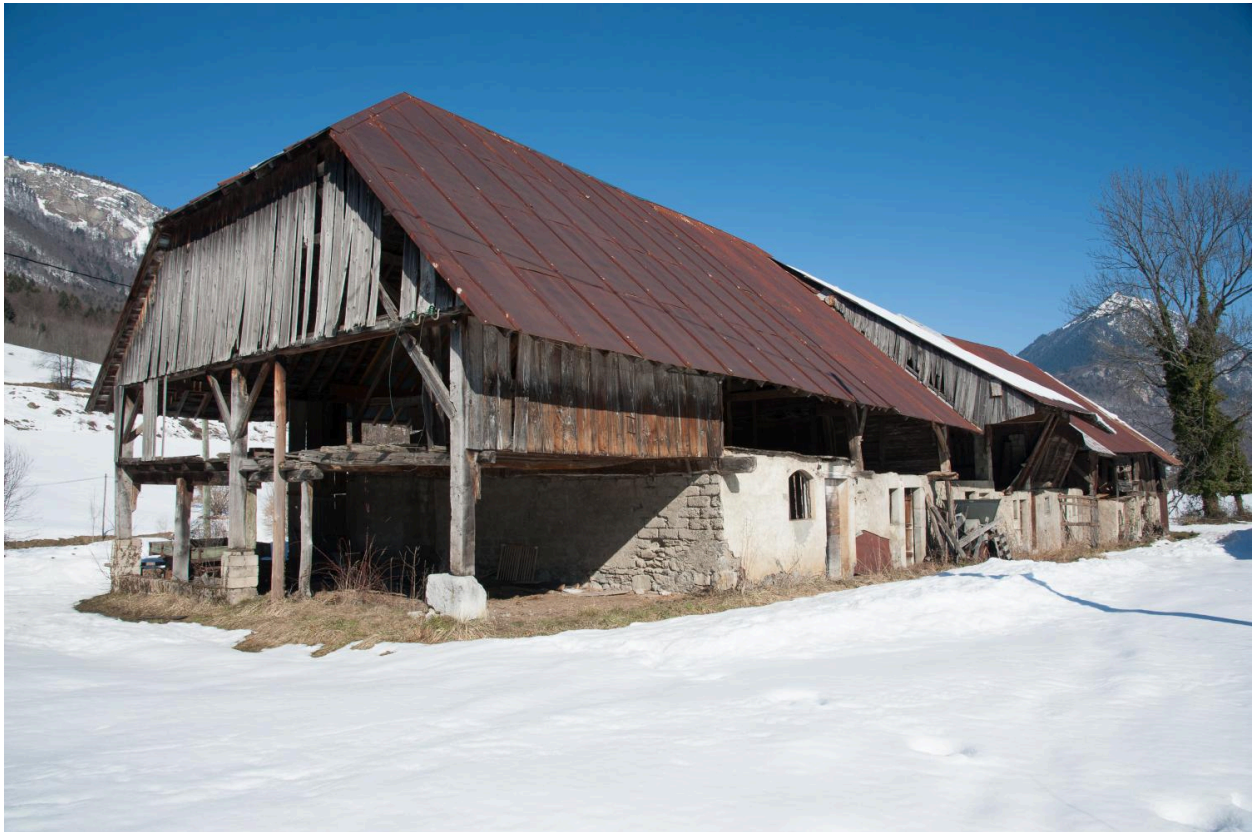
Vue de la partie couverte en pignon sud.
