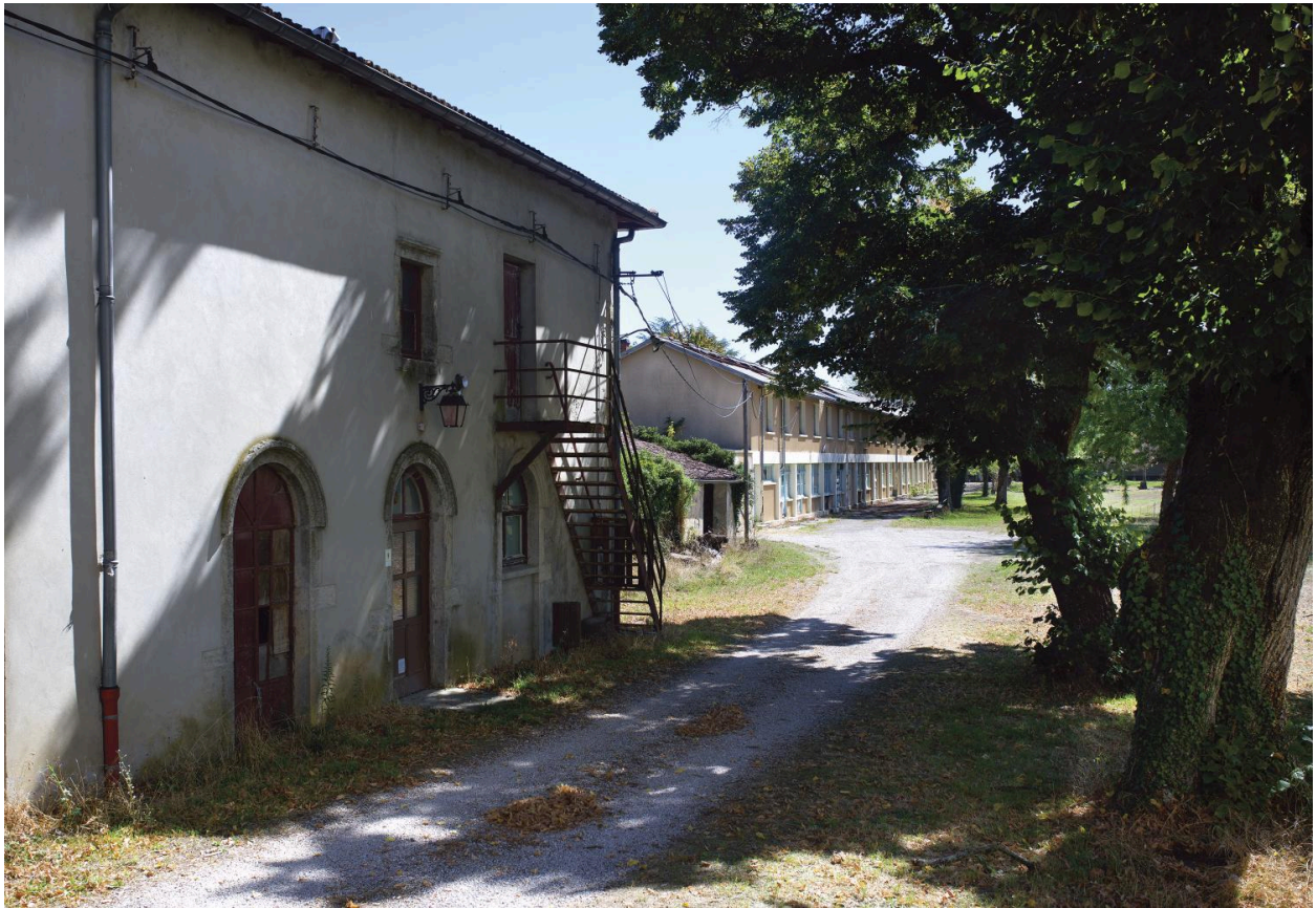
Vue de situation, avec le bâtiment de la colonie en arrière-plan
