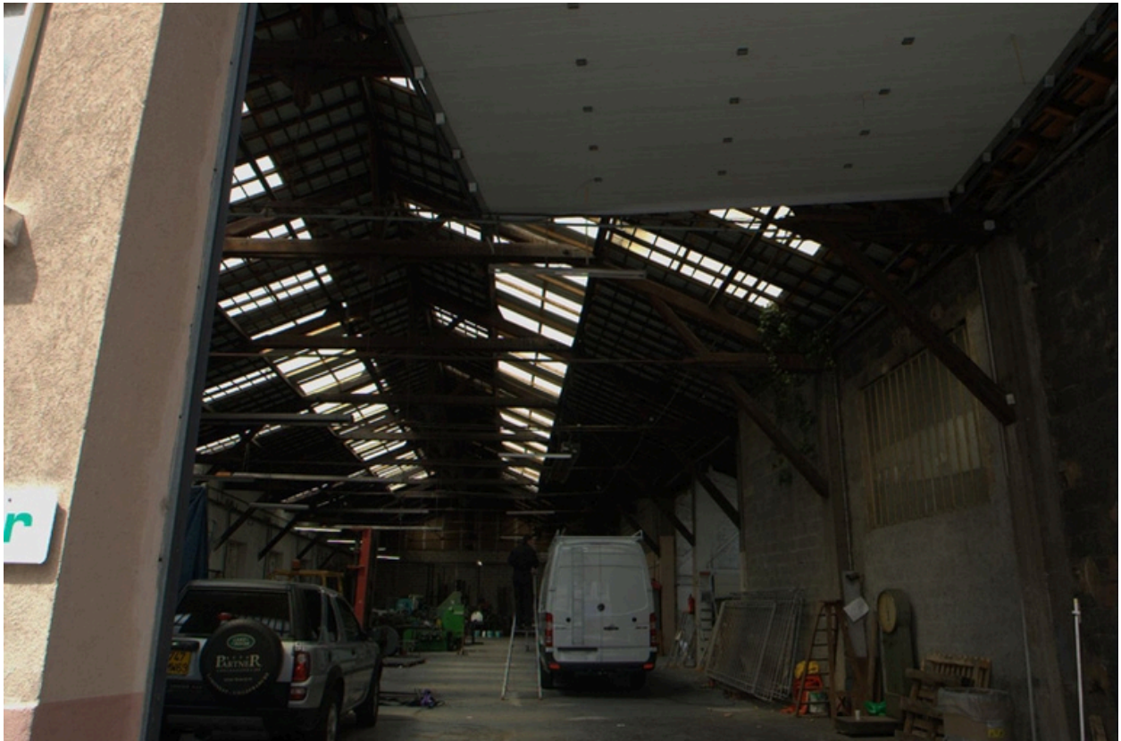
Vue intérieure de la halle Guignardat
