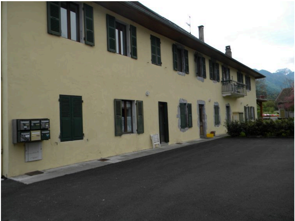
Façade ouest d'une ferme avec un large toit désaxé dans le quartier de la Glière (C5 2664).
