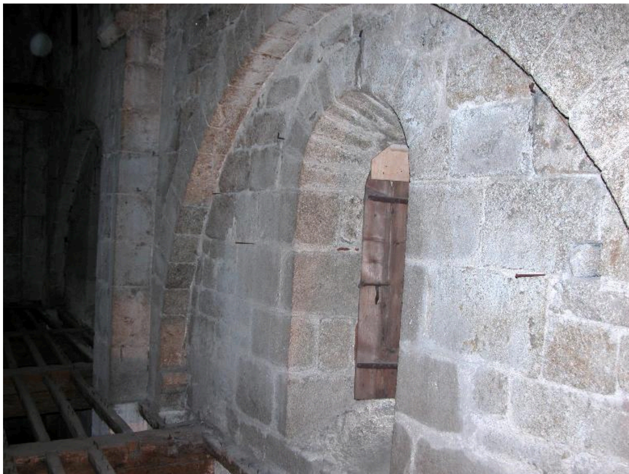
Vue intérieure (premier étage).
