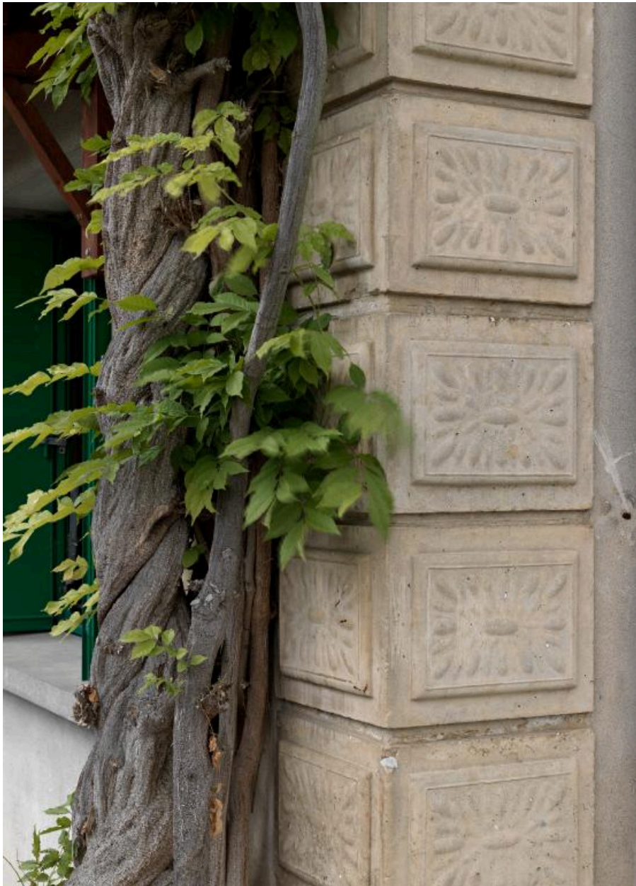
Détail des élévations de la quincaillerie : chaîne d'angle en béton moulé.
