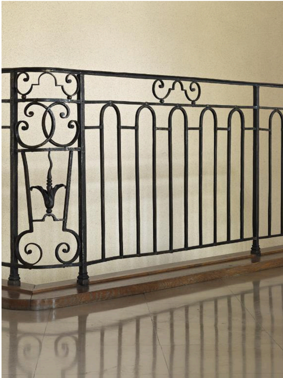
Administration, hall d'honneur, 1er étage : garde-corps de l'escalier principal
