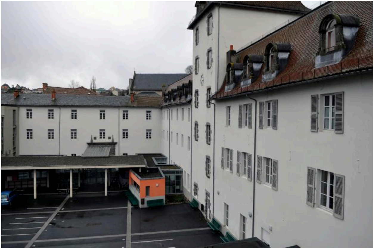
Cour, vue d'ensemble depuis l'est
