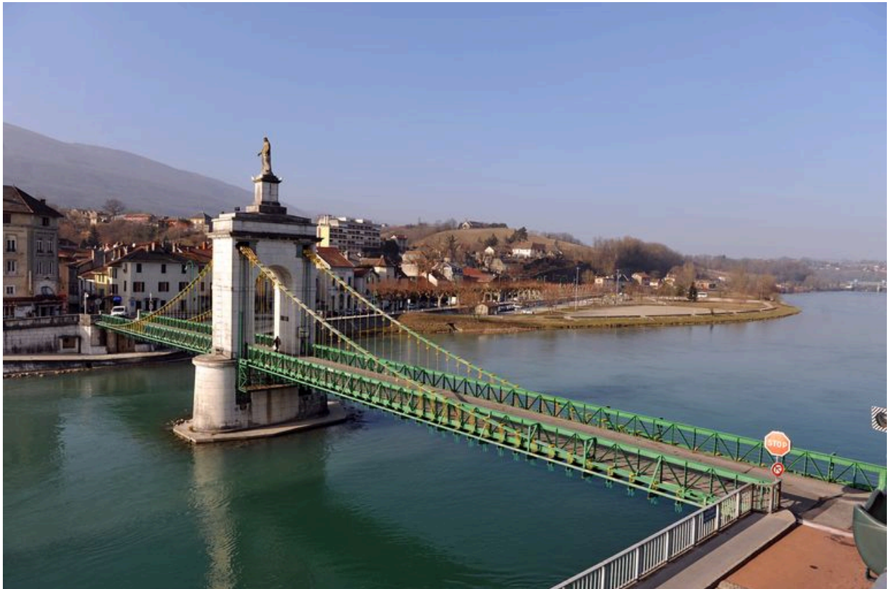
Vue générale, de côté, face amont (depuis la rive gauche, en hauteur)
