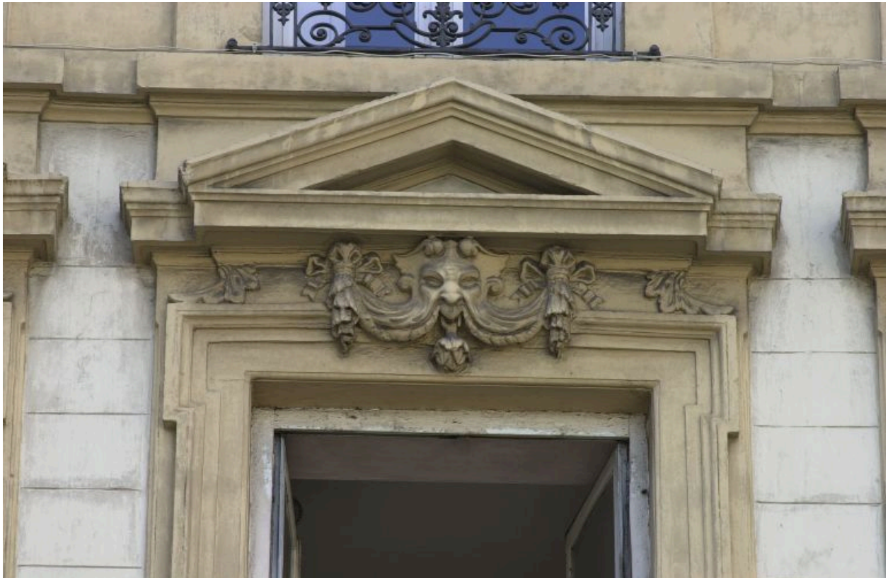
Façade principale, 4e niveau, détail de la 4e fenêtre
