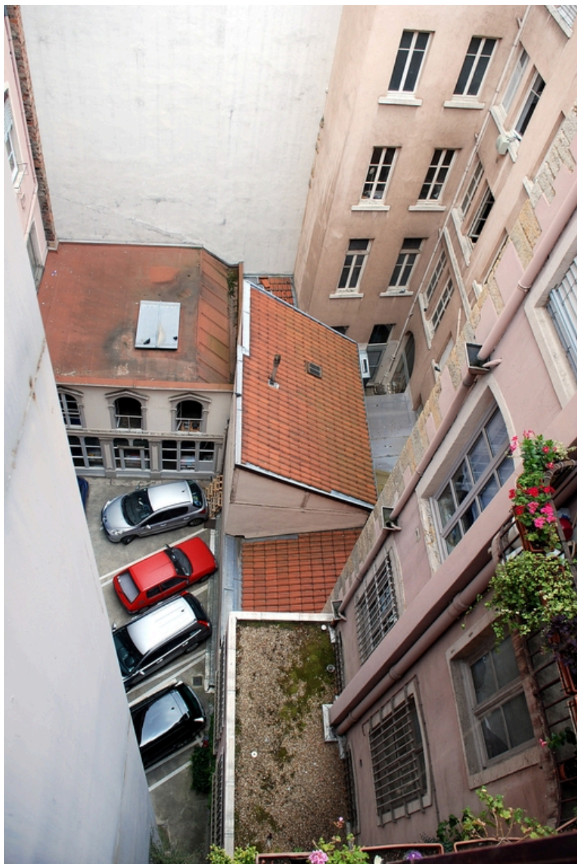
Cour nord : vue depuis l'escalier du 15 rue Emile-Zola
