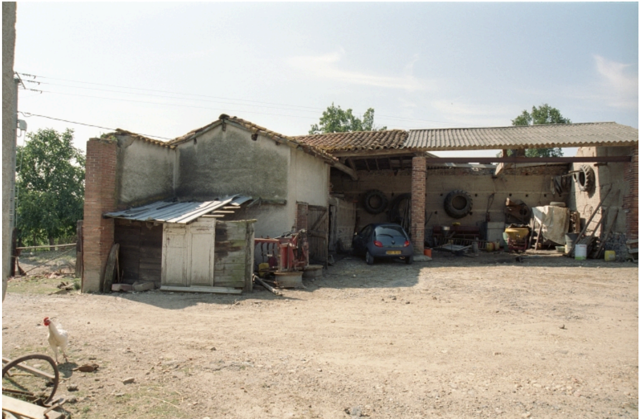
Vue du hangar et de l'entrée de la cour.
