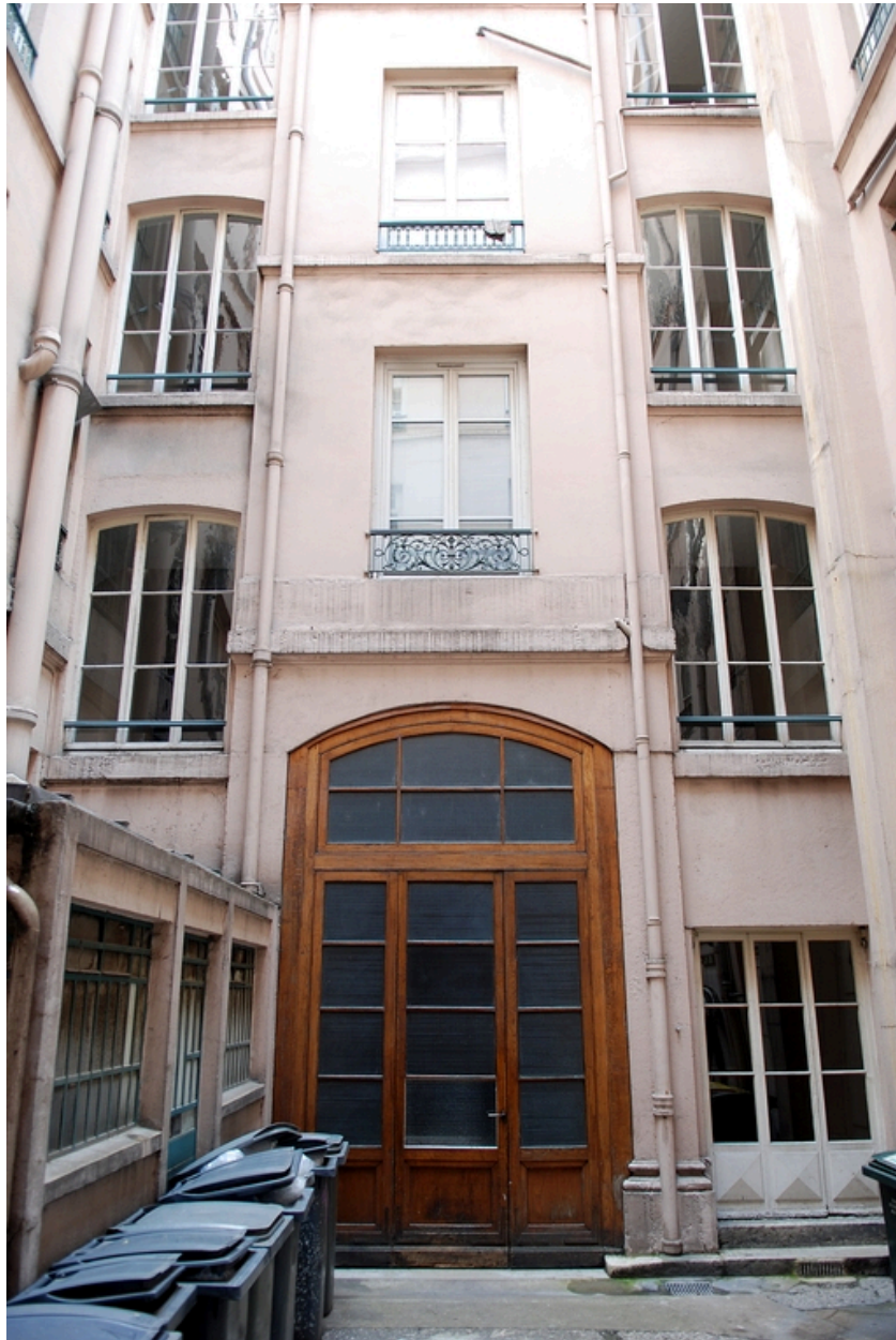
Elévation sur cour : partie inférieure
