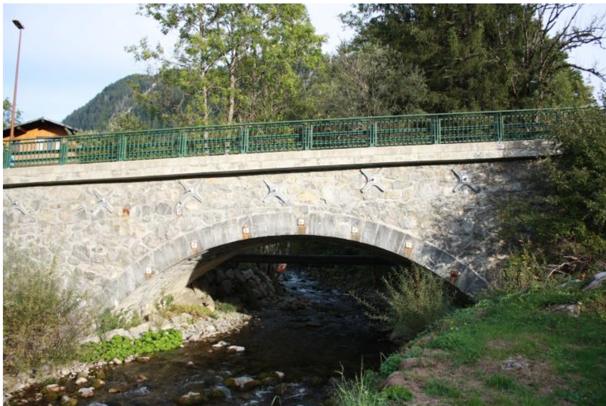
Pont de la Glières, face aval
