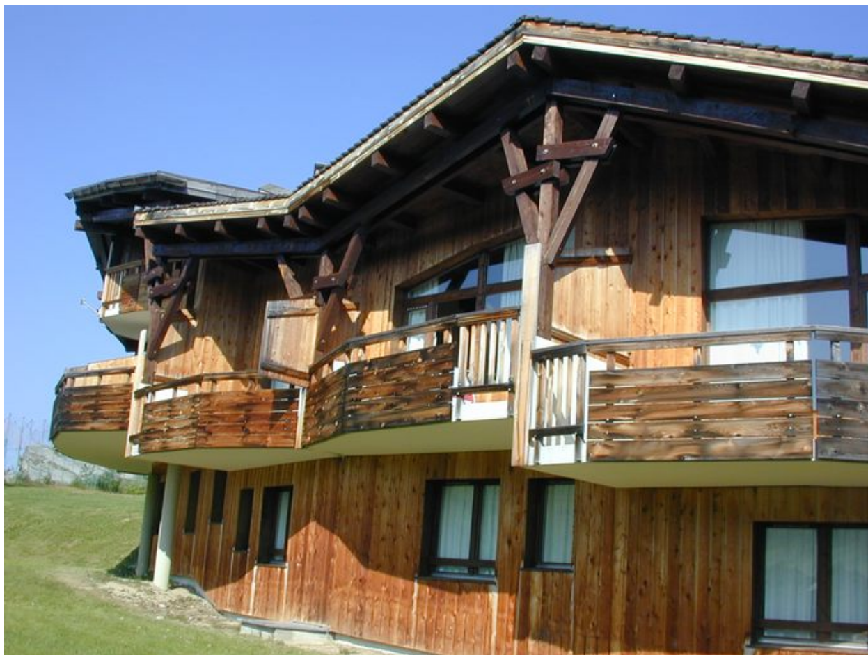
Elévation postérieure, côté ouest
