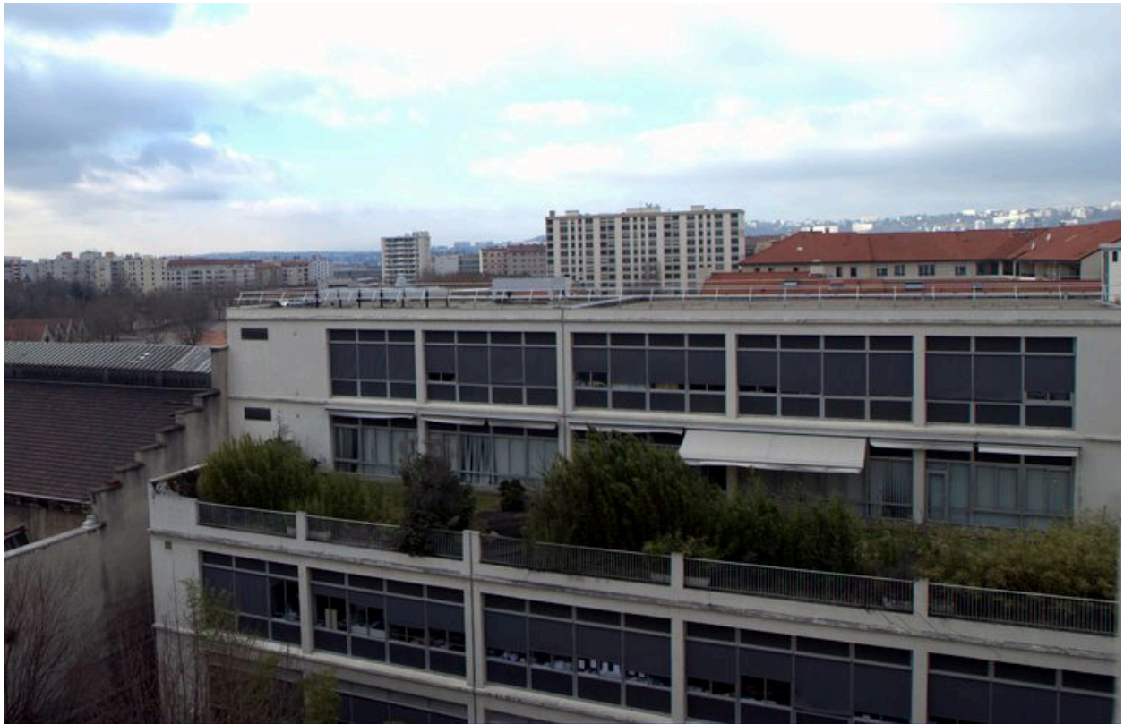
Elévation postérieure, vue partielle
