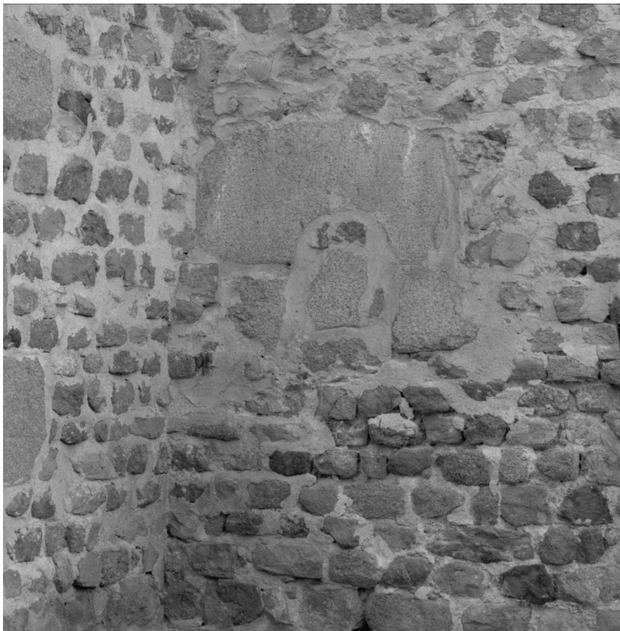
Détail de l'absidiole sud : baie murée à linteau monolithe.
