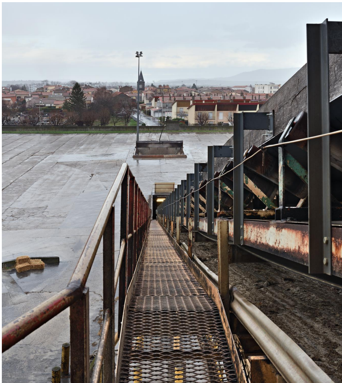
Cour à betteraves : stockages au sous-sol et tapis élévateurs
