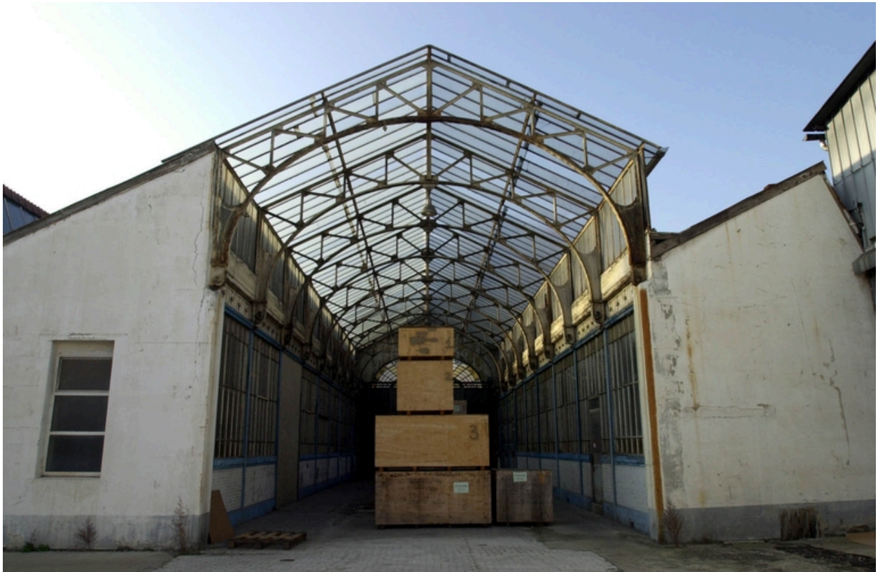
Verrière vue ouest
