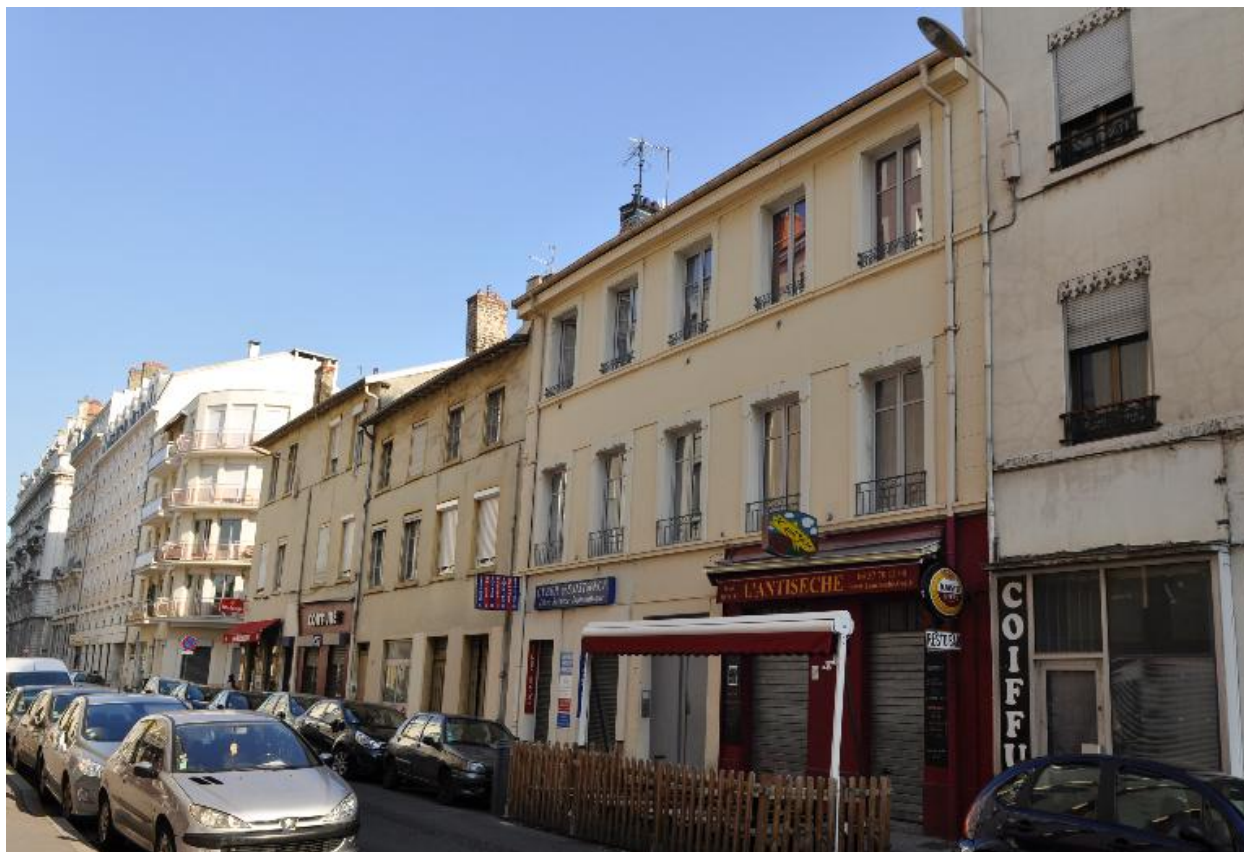
Immeuble sur rue, vue générale
