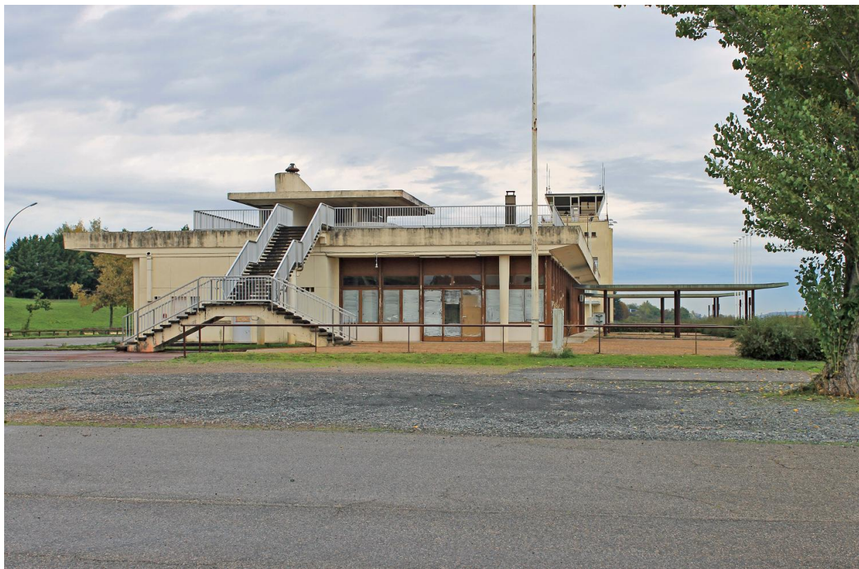
La façade sud de l'aérogare de Vichy-Charmeil.
