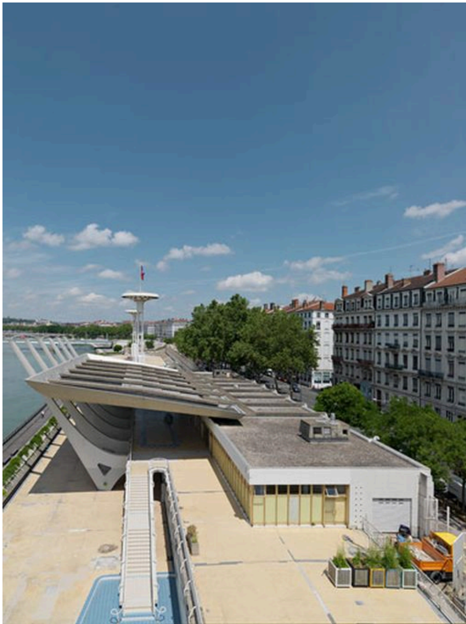
Vue du bâtiment d'exploitation depuis le sud (état en juin 2012).
